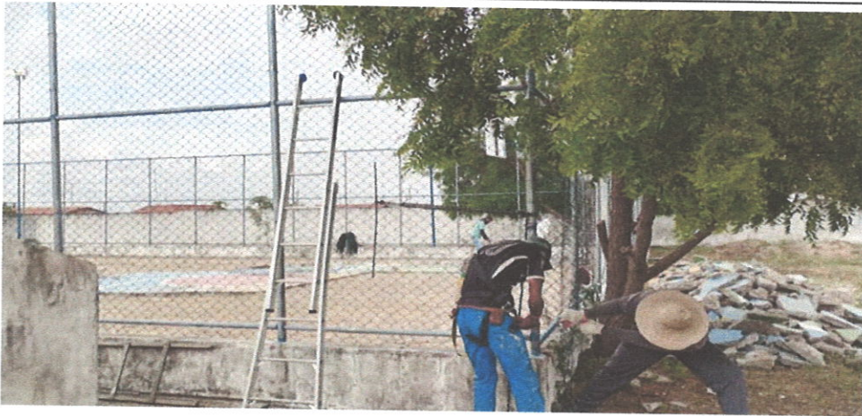
INSTALAÇÃO DE ALAMBRADOS
